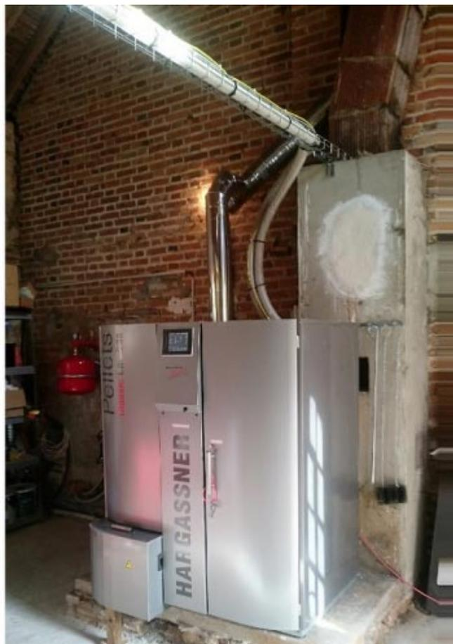
*Installation d'une chaudière à granulés Hargassner de 35KW et d'un silo XXL de 8 tonnes à Vannes sur Cosson dans le Loiret. Ce silo est calibré pour un an d'autonomie. En remplacement d'une chaudière fioul sur un plancher chauffant, maison de grand volume. Système économique avec une garantie totale de 7 ans. Ouvrant droit à un crédit d'impôt de 30% et une prime éco énergie.*
